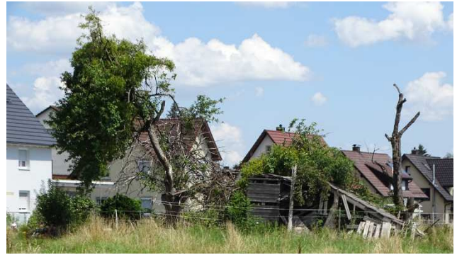
Foto 4: an der westlichen Plangebietsgrenze befindet sich ein zusammengebrochener Schuppen sowie abgehende bzw. bereits abgestorbene Obstbäume
