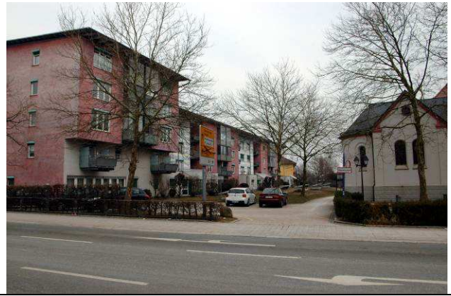
Foto 8: Wohnanlage der Zeppelin Wohlfahrt GmbH u. hist. Kapelle des Karl-Olga-Hauses
