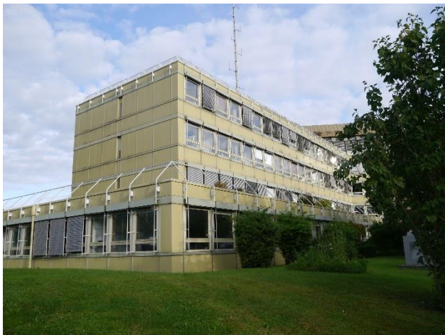
Foto 5: Für den Abbruch vorgesehenes Bestandsgebäude des Landratsamtes
