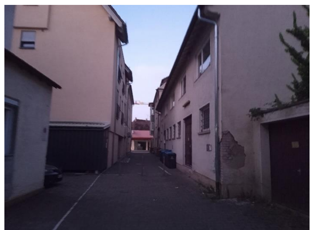
Foto 6: Wohnbebauung im Bereich der Laimgasse
