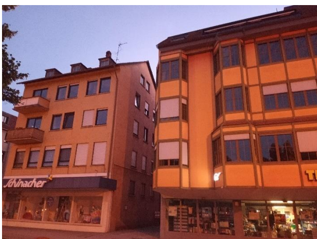
Foto 5: Blick von Friedrichstraße ins Plangebiet
