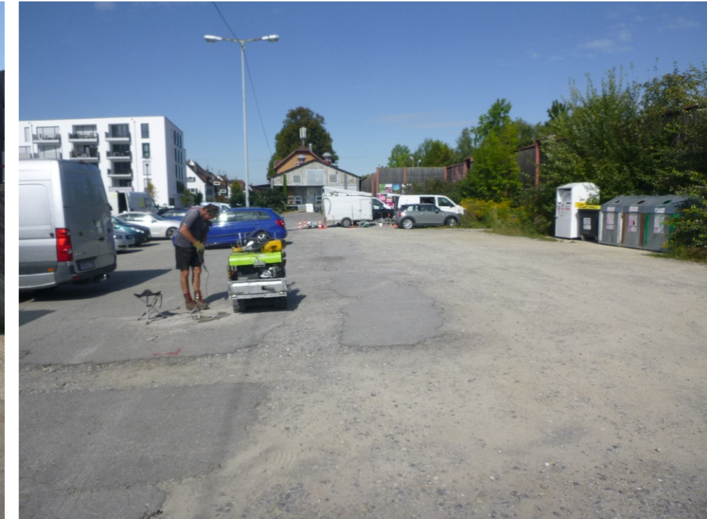
Bild 3: Blick nach Nordwesten über das Parkplatzgelände auf den Ansatzpunkt der Rammkernsondierung BS 3.
