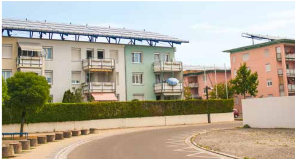
Kennzeichen der Solarsiedlung Wiggenshausen sind die großflächigen Sonnenkollektoren auf den Dächern der Mehrfamilienhäuser für die solar unterstützte Nahwärmeversorgung.
