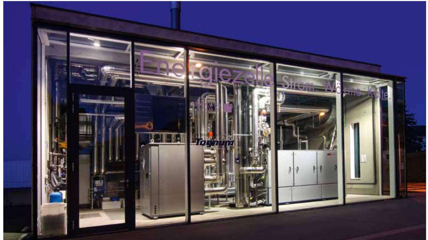
In einem gasbetriebenen Blockheizkraftwerk an der Hochstraße produziert das SWSee Strom, Wärme und Kälte für den Eigenbedarf der MTU/Tognum AG.
